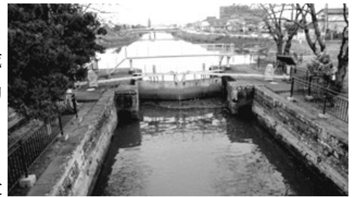
北上運河（石井閘門）
